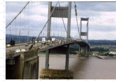
Severn Bridge 鋼床版の疲労き裂検討のはじまり 東京都市大学
