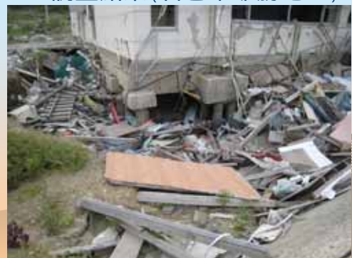
洗掘又は地盤液状化により露出した杭頭
