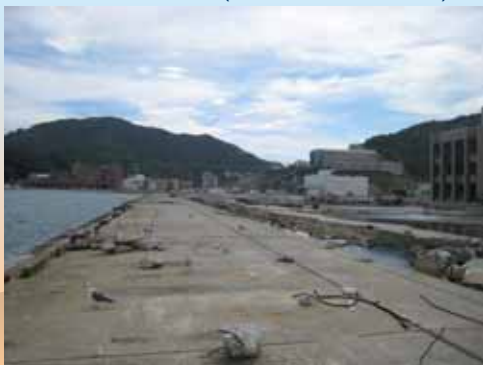
女川港岸壁(側方流動?)
