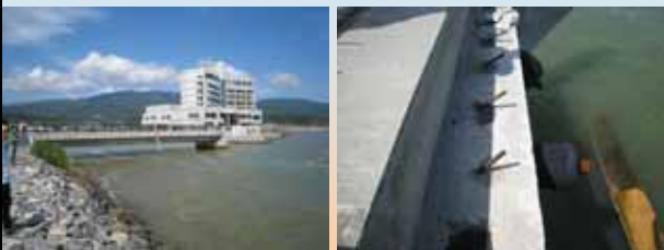
流失橋梁及び橋台
