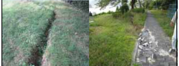
地震による法上に発生した亀裂
