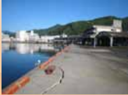
釜石港岸壁の変状(その1)
