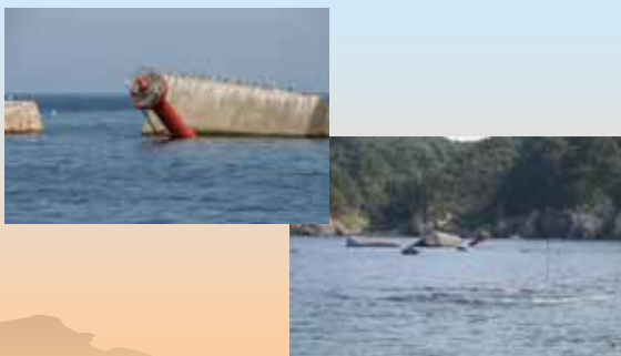
防波堤の破壊
