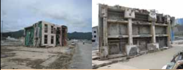
倒壊したビル(全景及び底面)
