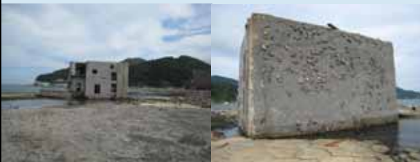
倒壊したビル(ベタ基礎)
