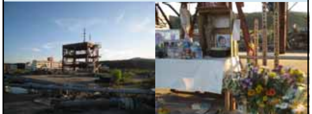
南三陸町防災対策庁舎
