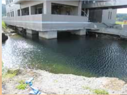
陸前高田浄化センター洗掘
