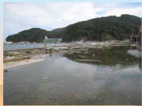
地盤沈下による冠水
