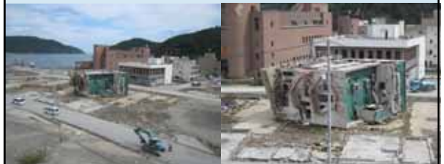
倒壊したビル(女川町立病院より)
