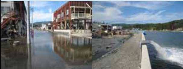
地盤沈下による冠水とポンプ排水
