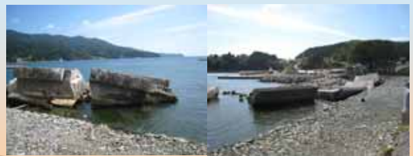
防潮堤の被害
