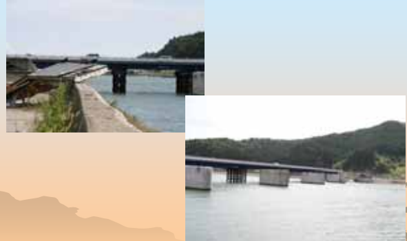
気仙大橋(仮設橋)
