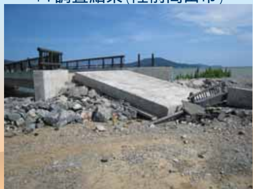
橋梁踏掛板の変状
