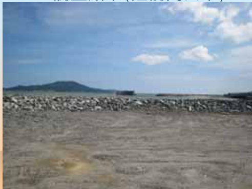
陸前高田応急復旧堤防
