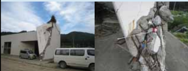
津波によるコンクリート版の破壊
