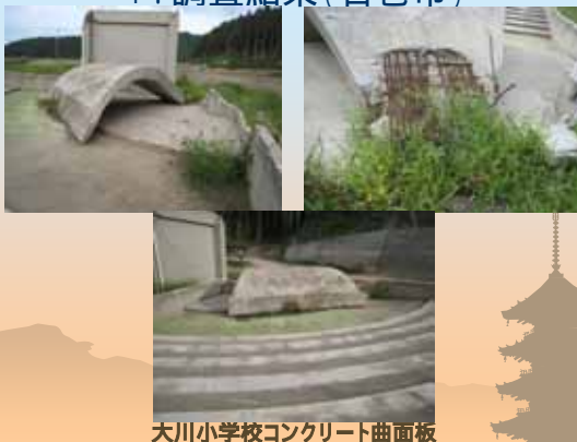
大川小学校コンクリート曲面板
