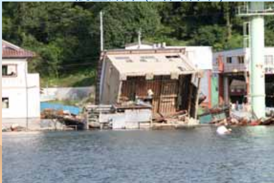
臨海工場建屋(アンカーボルト切断)
