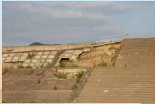
津波防潮堤背面(山側)被覆工の破壊
