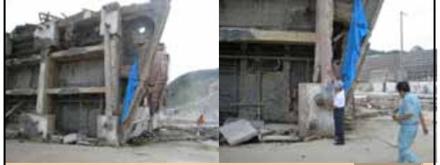
倒壊したビル(基礎杭)
