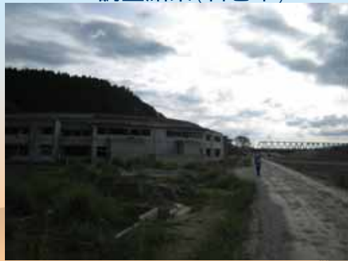
大川小学校及び新北上大橋
