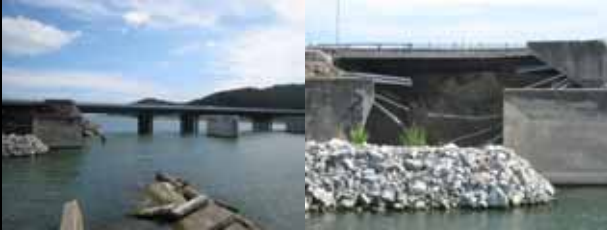
気仙大橋橋台裏吸い出し
