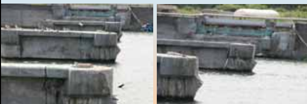
姉齒橋橋脚クラック(左岸より)
