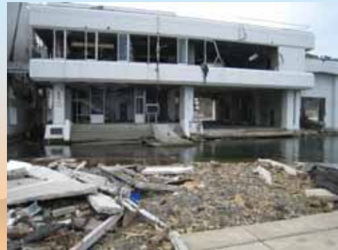
基礎の強固なビル(洗掘あり)
