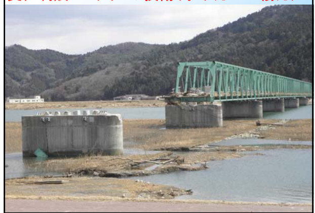
変位制限コンクリート損傷(水平力+上揚力)
