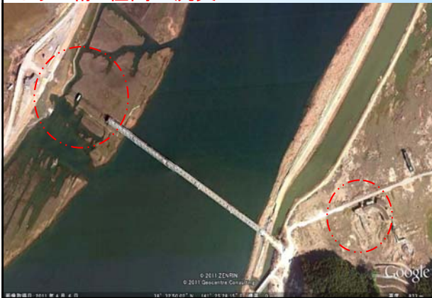
トラス桁2径間が流失
