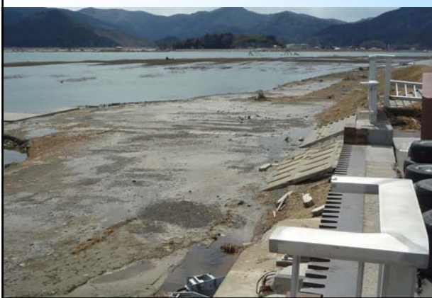
トラス桁400m移動
