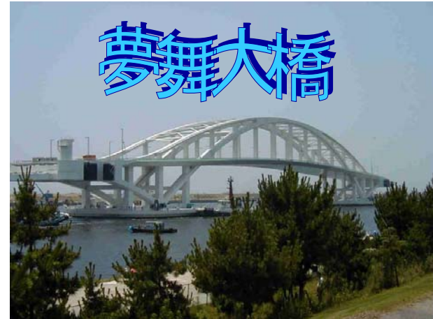
Yumemai Bridge, Osaka
